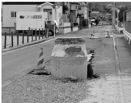
液状化で浮き上がったマンホール (宮城県白石市東町)
