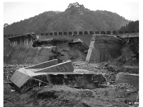
津波で破壊された防潮堤 (岩手県宮古市田老地区)
