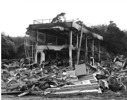
骨組みだけ残った鉄骨建物 (福島県いわき市豊間地区)
